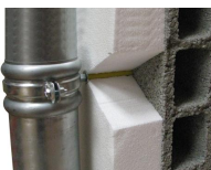
Collier de descente d'eaux pluviales - vue en situation
